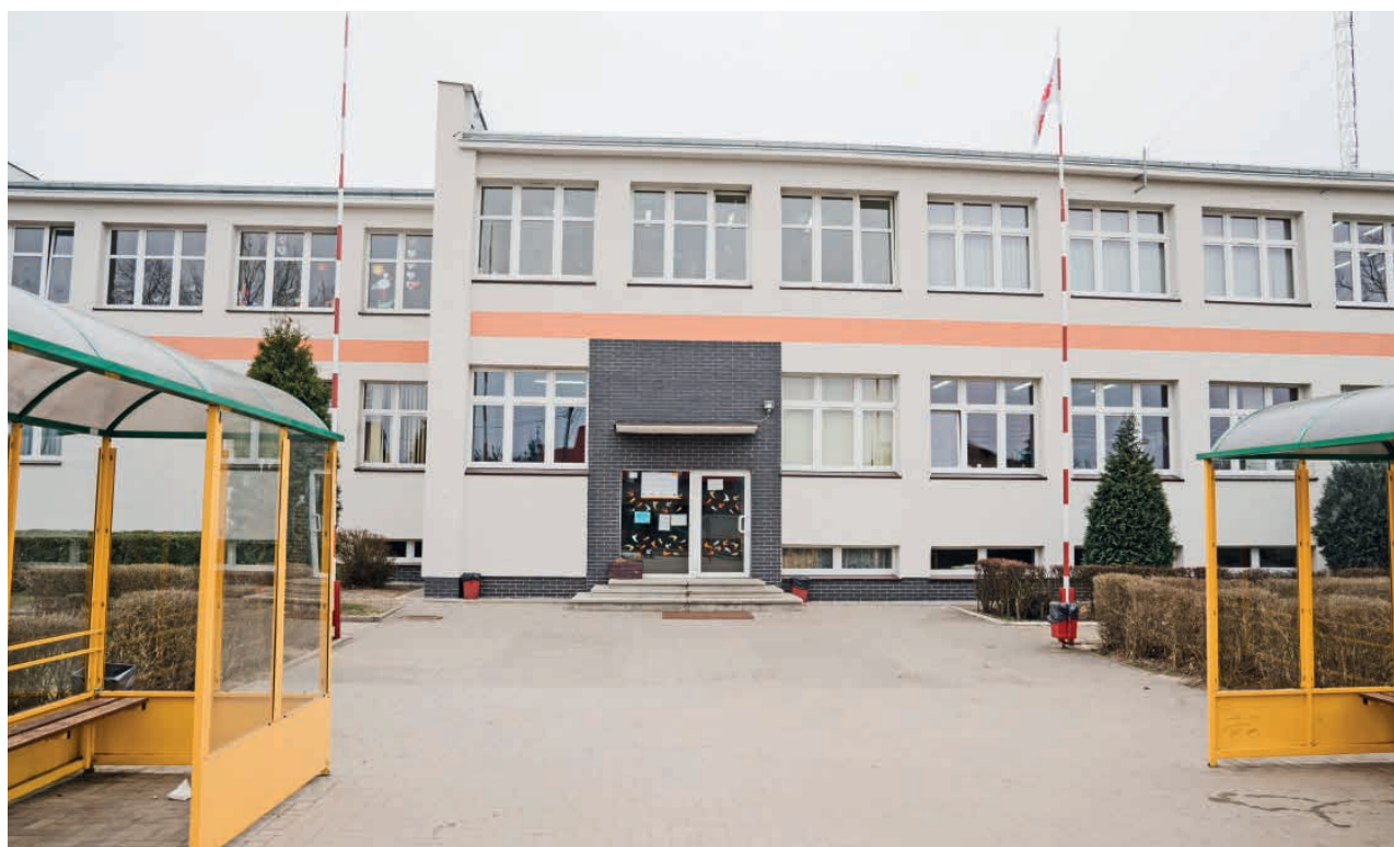
Termomodernizacja Szkoły Podstawowej w Sułowie.
